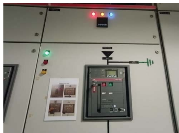
รูปที่ 2-23 ชุด Power Monitoring บริเวณตู้ MDB
