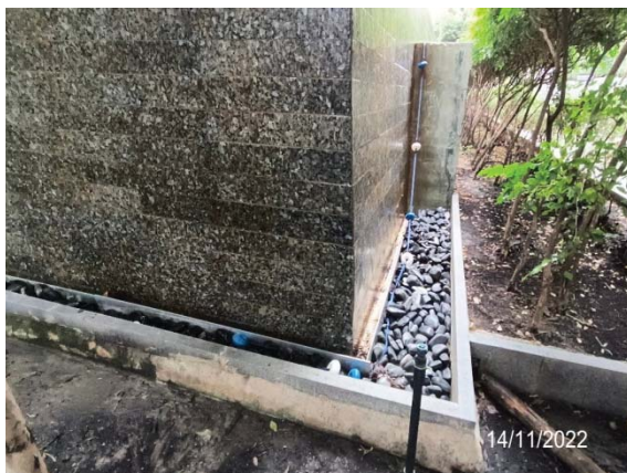
รูปที่ 2-34 รางระบายน้ำล้นรอบสระว่ายน้ำ
