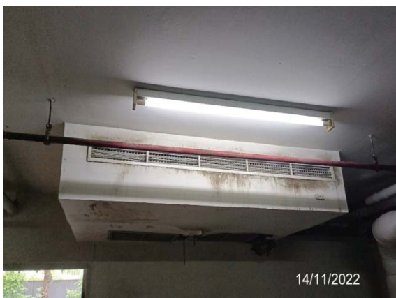
รูปที่ 2-22 การติดตั้งเครื่องระบายอากาศในห้องพักขยะ
